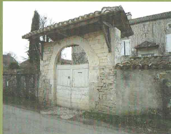
Porche près du lavoir (Aujols) GPS : 44°24'29" N / 01°32'57" E
